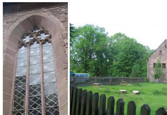
Amelungsborn, Buntglasfenster und Zaunanlage
