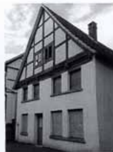
Das Haus an der Homburgstraße 62 soll demnächst abgerissen werden. FOTO: MS
